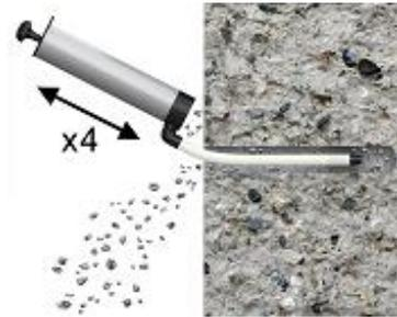
Bohrmehl und Schmutz aus dem Loch entfernen
